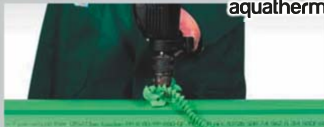
Bušenje stijenke cijevi
