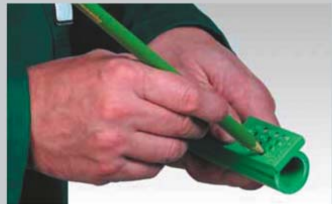
Označavanje dubine zavarivanja
