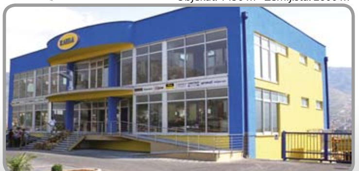
KANILA d.o.o. Mostar Objekat: 1450 m 2 Zemljišta: 2600 m 2
