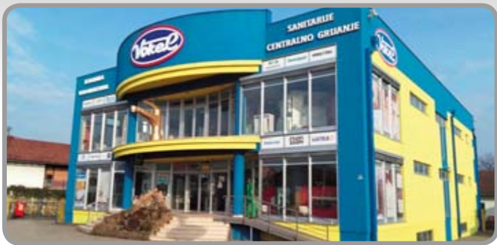
VOKEL d.o.o. Laktaši Objekat: 2300 m 2 Zemljišta: 3400 m 2
