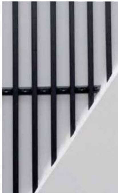
Zid / strop (u žbuci)
