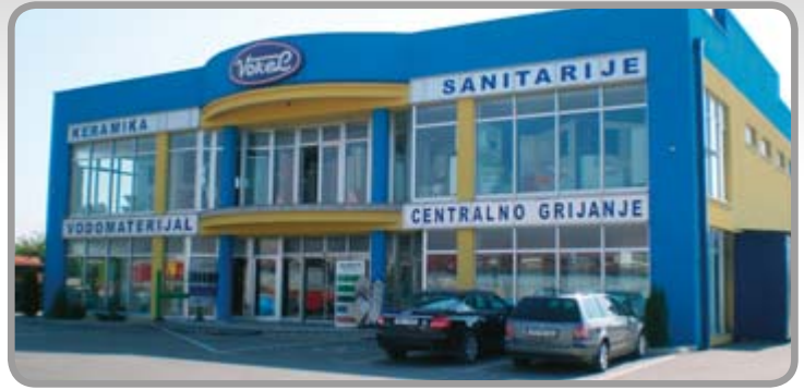
VOKEL d.o.o. Prijedor Objekat: 1250 m 2 Zemljišta: 3800 m 2
