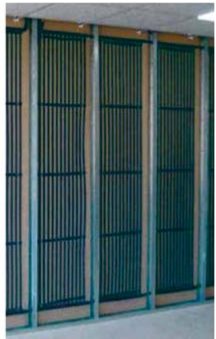
Zid (podkonstrukcija za suhu ugradnju)
